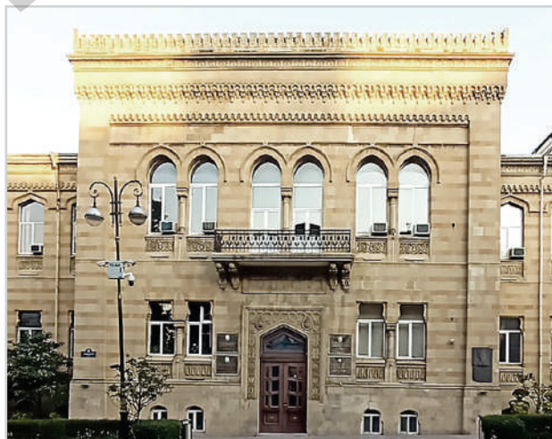
Qızlar məktəbinin binası (indi Əlyazmalar İnstitutu)
