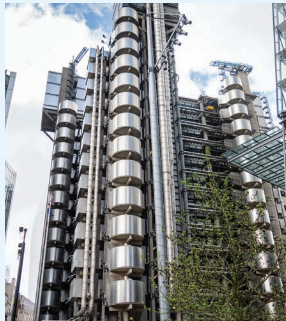
Lloyds binası (Londonda)
