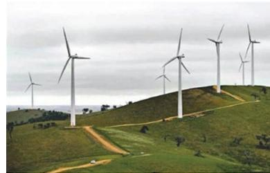
**Külək elektrik stansiyaları (KES)** – enerjini hava axınlarından əldə edir. Bir turbin (külək generatoru) 600–800 ev üçün elektrik enerjisini istehsal edə bilər. KES-in normal fəaliyyət göstərməsi üçün küləyin orta illik sürətinin 4,5 m/san olması vacib şərtidir. KES enerjisi Danimarka və Niderlandın yanacaq-enerji balansında əsas yer tutur. Azərbaycanda isə KES-in gücünün 4,5 QVt olacağı proqnozlaşdırılır.
