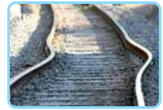
Relslər istilikdən genişləndiyi üçün əyilir
