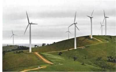
**Ветровые электростанции** вырабатывают энергию от воздушных потоков. Одна турбина (ветрогенератор) может производить электроэнергию для 600–800 домов. Для нормальной работы такой электростанции необходимым условием является наличие ветра со среднегодовой скоростью 4,5 м/с. Электроэнергия ветра имеет большую долю в топливно-энергетическом балансе Дании, Нидерландов. Прогнозируется, что доля ветровой энергии в топливно-энергетическом балансе Азербайджана составит 4,5 ГВт.
