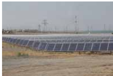
(б) Гелиоэлектростанция. Сумгайыт.
