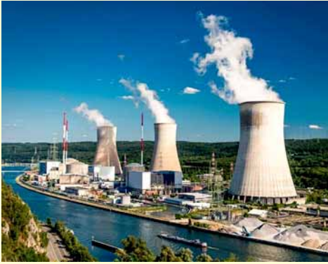
▲ Atom elektrik stansiyası
