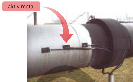
Aktiv metal polad borunu korroziyadan qoruyur
