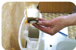
Şəkil 4. Pərdənin yenisi ilə əvəzlənməsi
