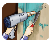
Şəkil 1. Rəngin çıxarılma üsulları: a, b – mexaniki, c – termik
