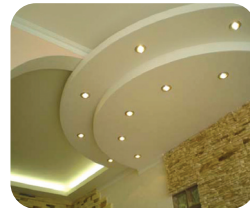
Şəkil 6. Işıqlandırılması olan gipskarton lövhələrdən yığılmış asma tavan
