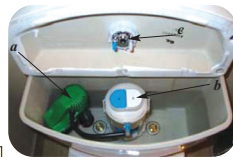
Şəkil 2. Axıdıcı çənin əsas tərkib hissələri: a – buraxıcı və doldurucu armatur; b – boşaldıcı mexanizm; c – su axıtma düyməsi
