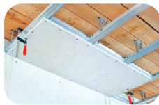
Şəkil 8. Gipskarton lövhələrin bərkidilməsi
