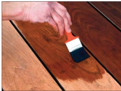
ნახ.2. „მორილკის“ დატანება ხის ზედაპირზე.
