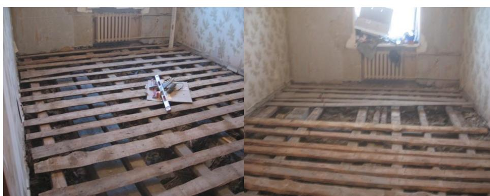
Şəkil 3.17. Döşəmənin alt ağaclarının dəyişdirilməsi və nizamlanması
