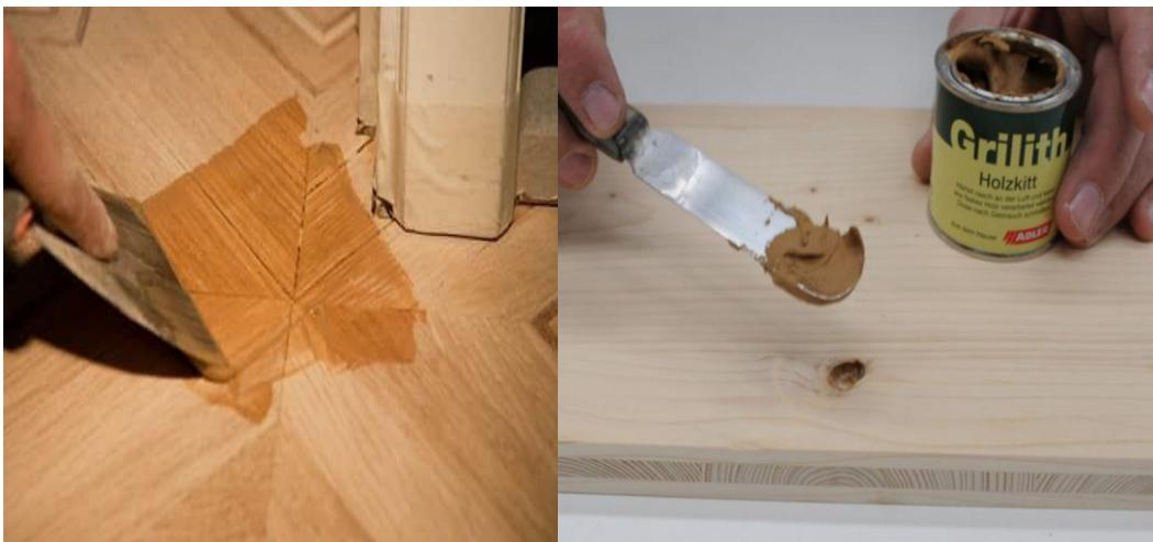
Şəkil 2.16. Taxta tozu və PVA yapışqanı ilə hazırlanmış qarışığın yaxılması qaydaları
