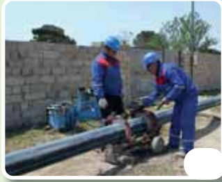
Su borularının təmiri
