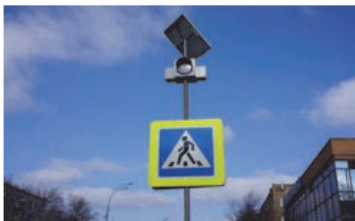
Знак пешеходного перехода, работающий на солнечных батареях. Батареи днем накапливают солнечную энергию, а ночью используют ее.
