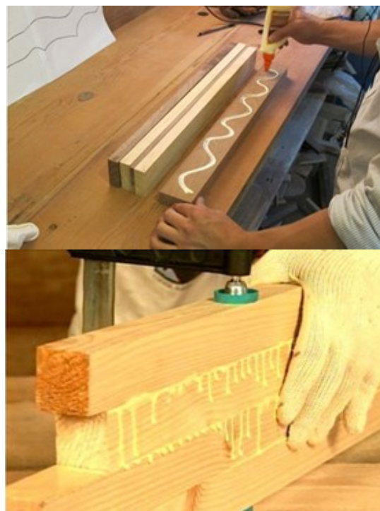
Şəkil 2.63. Ağacın yapışqanla birləşdirilməsi
