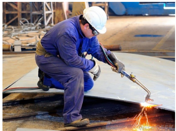
Şəkil 6.23. Qaz qaynağı
