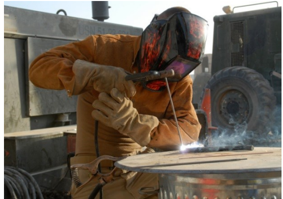
Şəkil 6.22. Elektrik qaynağı
