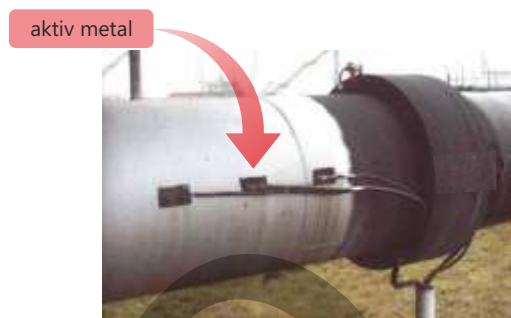
Aktiv metal polad borunu korroziyadan qoruyur
