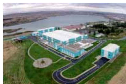
Станция для очистки воды в Джейранбатанском водохранилище
