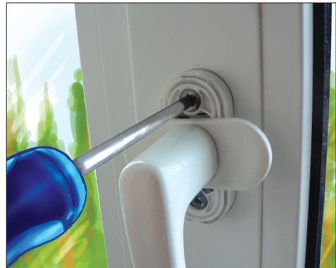
*Şəkil 5. Pəncərənin dəstəyinin çıxarılması*
