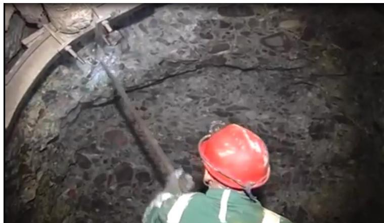
*Şəkil 2.22. Partlayışdan əvvəl qazma dibində uçub tökülmə təhlükəsi olan sűxur tikələrinin götürülməsi*
