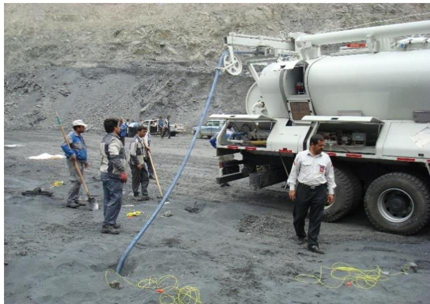
*Şəkil 2.26. Quyuların mexanikləşdirilmiş doldurulması*
