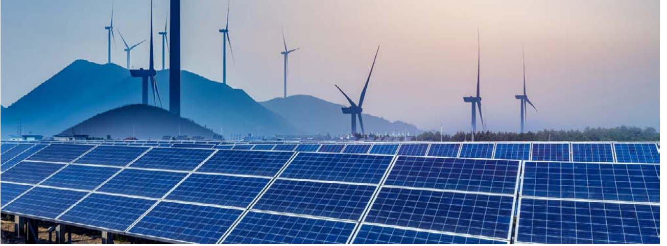
Ş.3.21. Hibrid yaşıl elektrik stansiyası.
